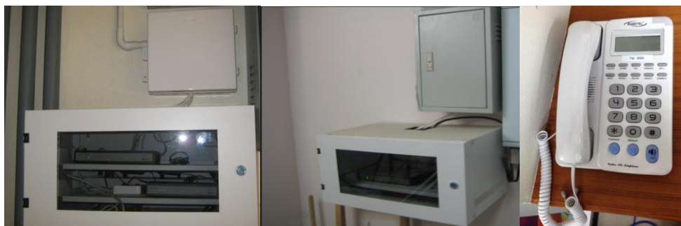
รูปภาพที่ 3 การติดตั้งจุดใช้งาน VoIP แบบควบคุมจากศูนย์กลาง
